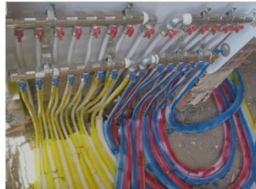
شکل ۵: لوله کشی کلکتوری
