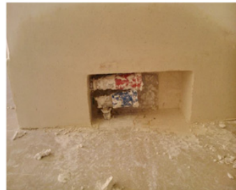
شکل ۶: لوله کشی انشعابی
